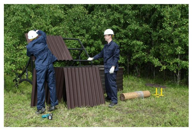
8. Примеряем коньковый элемент, отмечаем точки крепежа.
