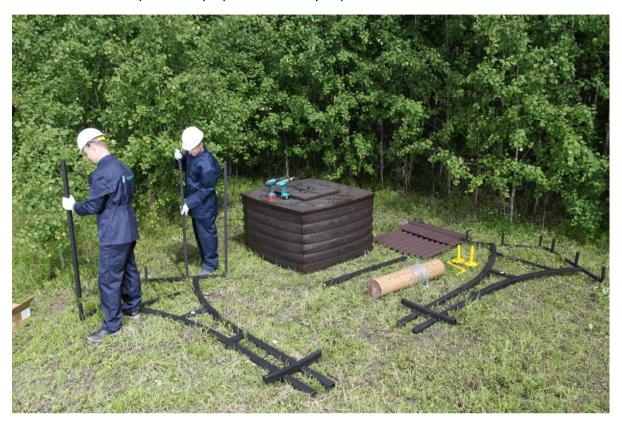
4. Установить вторую стойку каркаса, развернуть и положить конструкцию на землю. Закрепить поперечины к каркасу саморезами в предназначенные отверстия.
