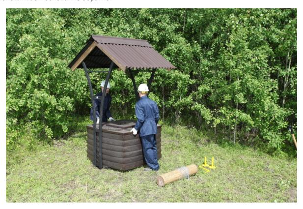
12. Собираем ворот колодца, устанавливаем металлические части в предназначенные отверстия и закрепляем саморезами.
