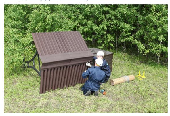
10. Устанавливаем деревянные элементы. Выставляем край доски по срезу профиля, закрепляем саморезами через предназначенные отверстия.
